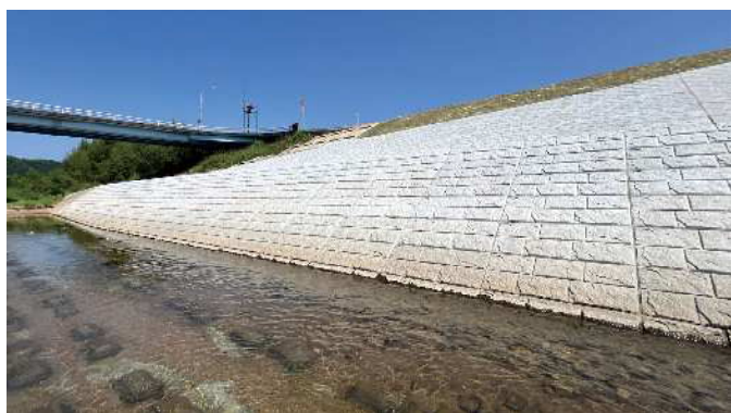
竣工後の様子 1
