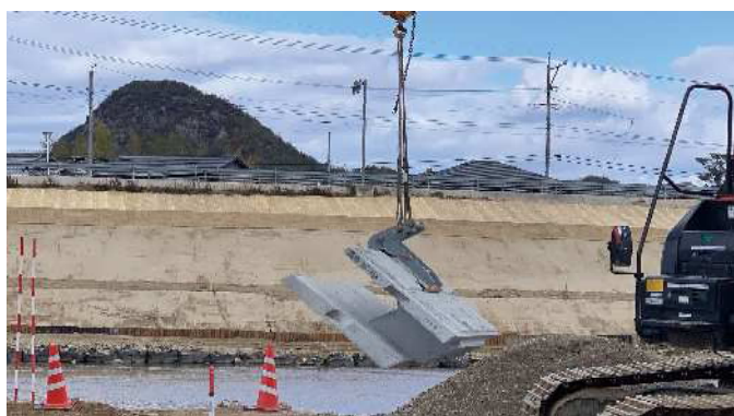
2. 専用治具でブロック本体を吊る
