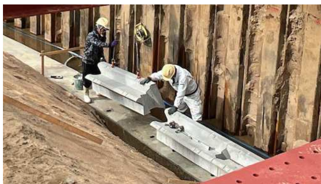
1. 基礎ブロックを据える (2)
