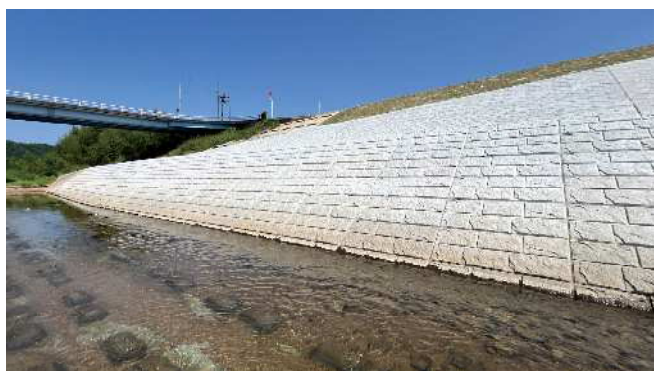
竣工後の様子 1
