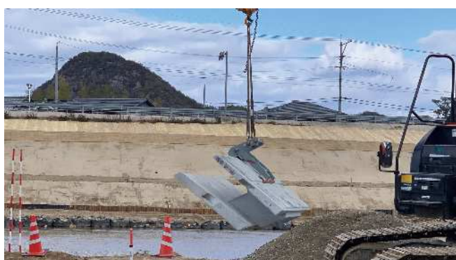
2. 専用治具でブロック本体を吊る
