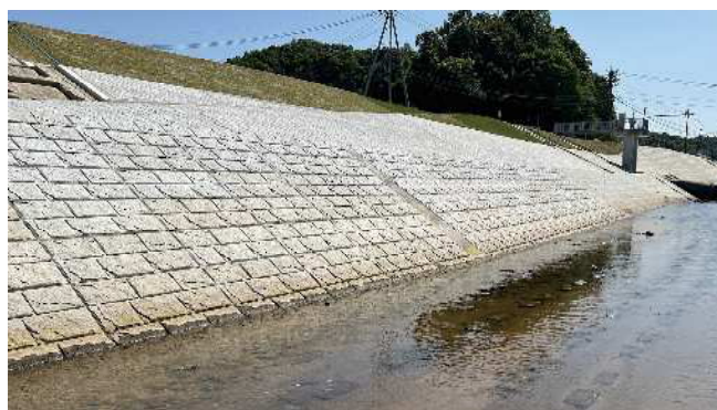
竣工後の様子 2
