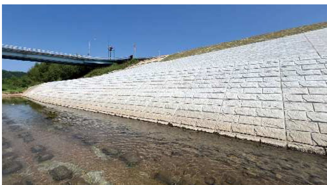
竣工後の様子 1
