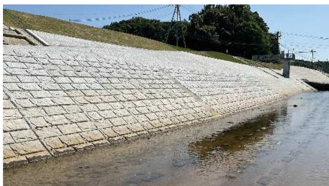
竣工後の様子 2
