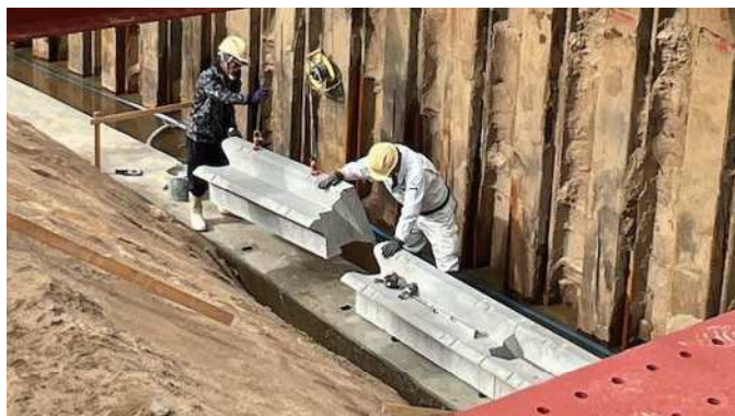
1. 基礎ブロックを据える (2)
