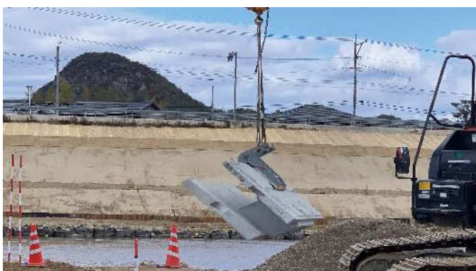
2. 専用治具でブロック本体を吊る
