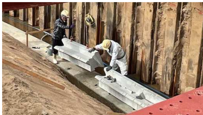
1. 基礎ブロックを据える (2)
