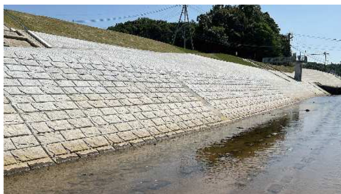
竣工後の様子 2
