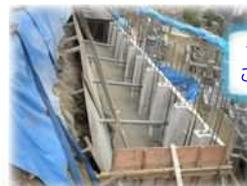
**Point1** 逆T擁壁と同じ擁壁高さのバランス工法擁壁では、環道の通行が可能のままの設計が可能です。
