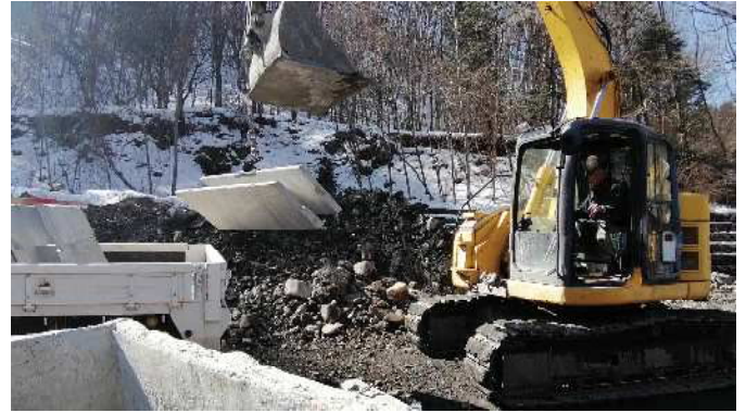
2. 専用治具でブロック本体を吊る
