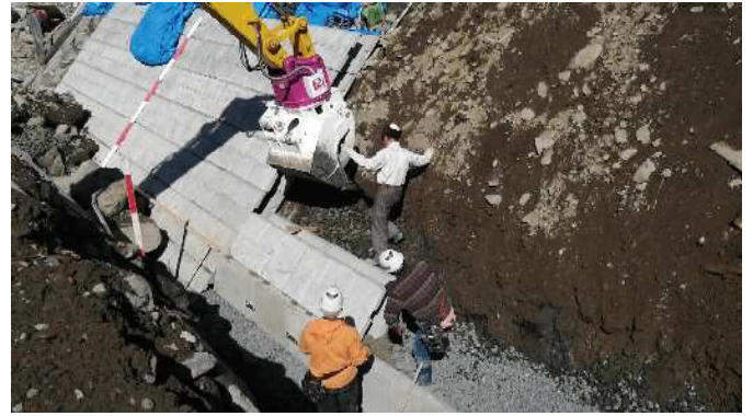
4. 裏込材を入れながら積んでいく
