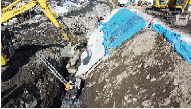
1. 基礎ブロックを据える
