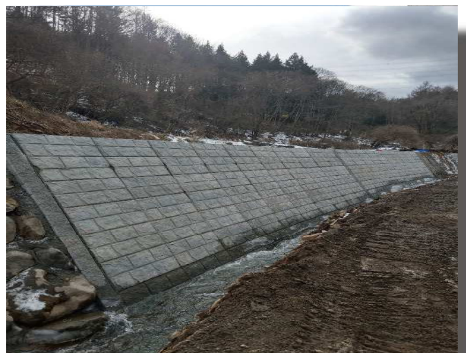
長野県小県郡長和町
